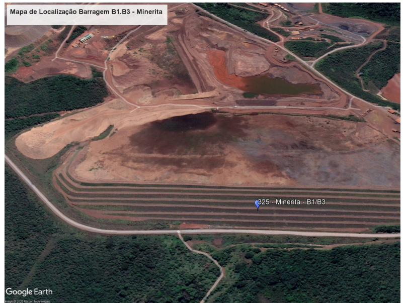
Imagem 1: Barragem B1.B3. Fonte: Google Earth, 2025.
